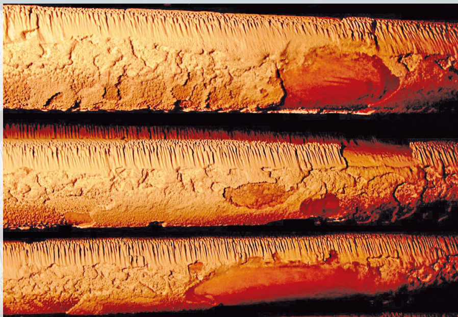
In Biomasse-Kraftwerken kann Asche als fester Belag die Wärmetauscher überziehen und in ihrer Funktion beeinträchtigen.
