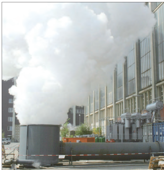
Die Therm Service GmbH führt als Projektleiter Engineering, Beizung, Abwasseraufbereitung und Dampfblasen im Biomasse-Heizkraftwerk Simmering durch
